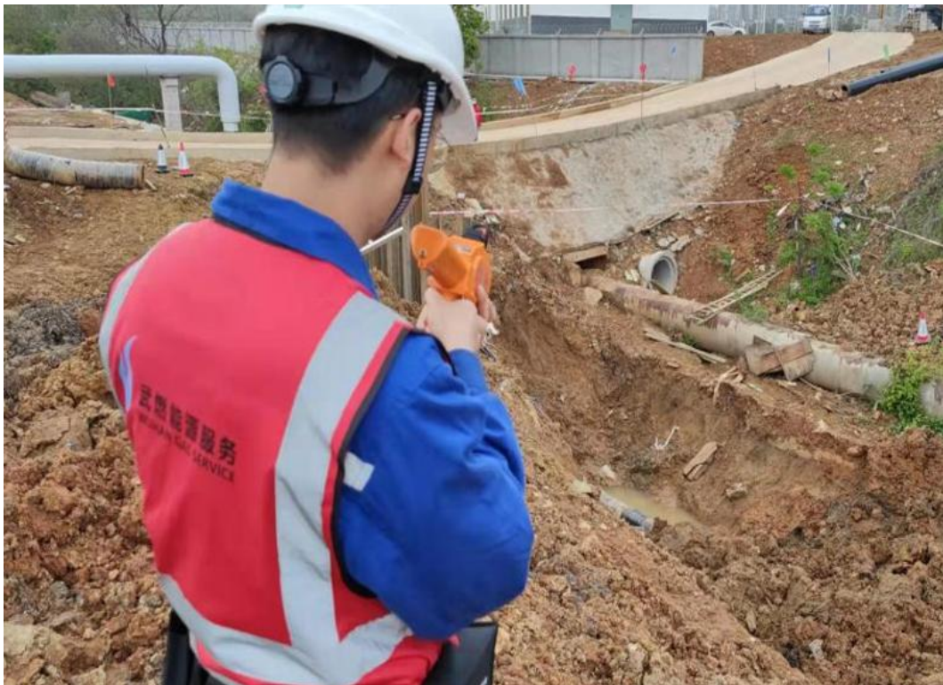
巡护人员使用手持激光泄漏检测仪对作业坑进行燃气泄漏检测
