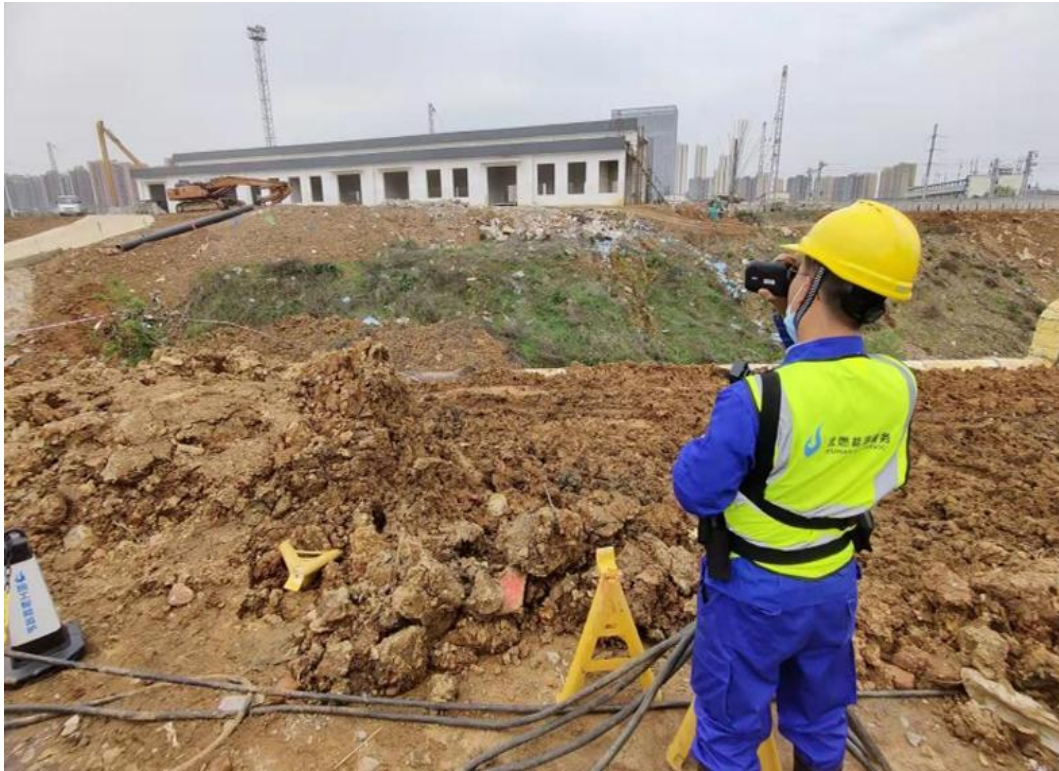
巡护人员使用红外测距仪确认施工机具与管线距离
